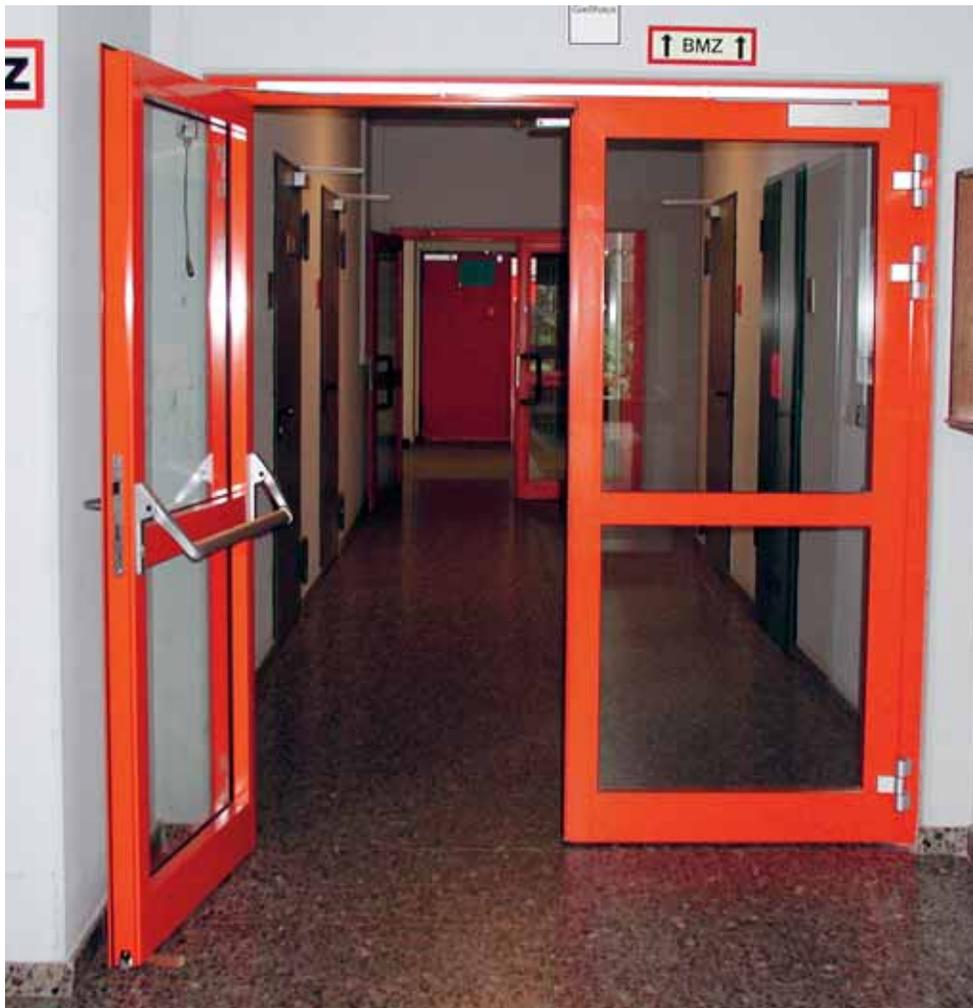
Abb. 1: Aufkeilen einer selbstschließenden Brand- und Rauchschutztür
